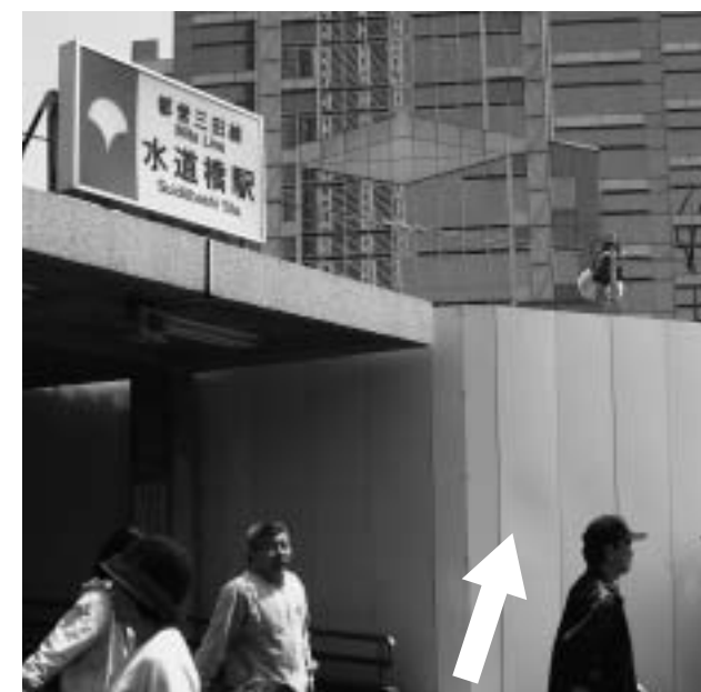
この塀の奥にエレベーターが設置されます
