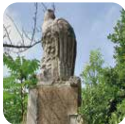
鷲の彫刻 亀裂や剥離部分を確認しつつ、洗浄も丁寧に行い、補修作業を進める。
