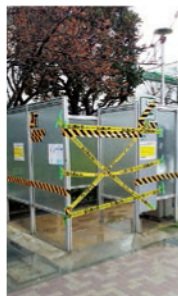
廃止された 礒川公園喫煙所
