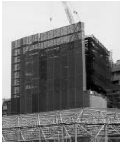
建設がすすむ根津1丁目の区立住宅
