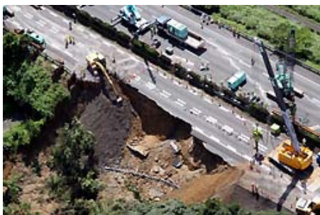
崩れ落ちた東名高速道路
