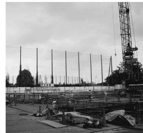
音羽中学校新築現場
