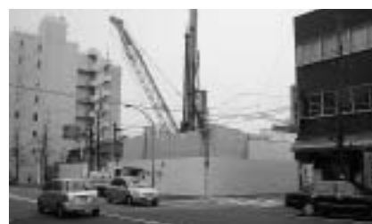
着工した80mマンション
