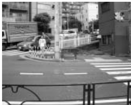
早期改善が必要な安藤坂交差点
